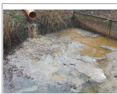
vyústění kanalizace do rybníka
