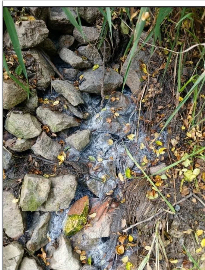
vyústění kanalizace do vodního toku
