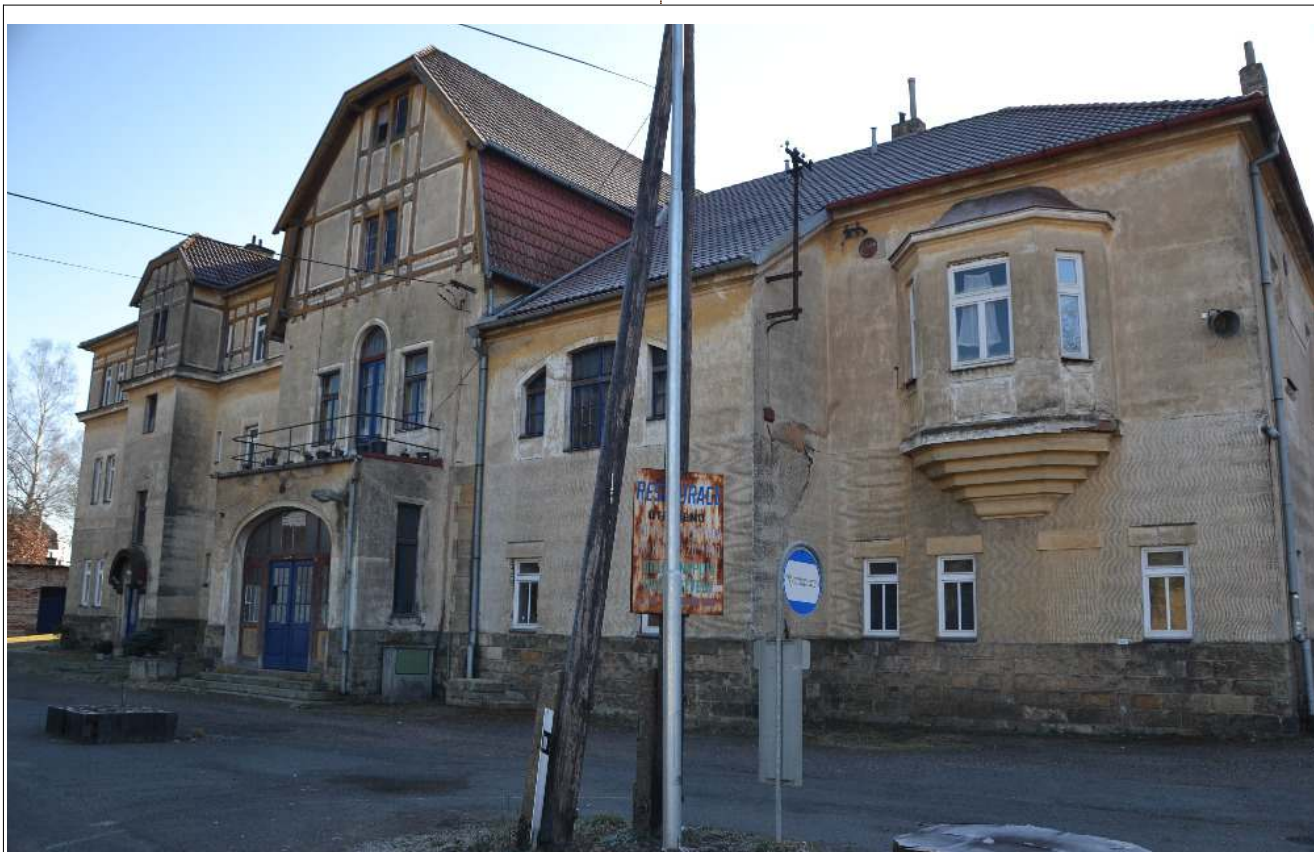
Pohled na nádražní budovu od silnice z 7.3. 2021
