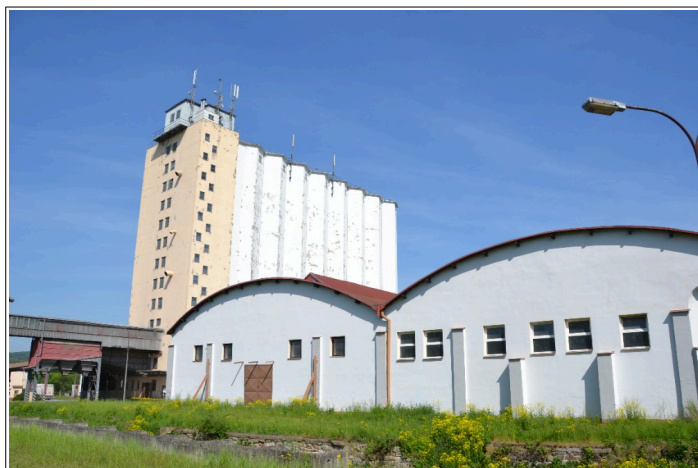
Silo a zrekonstruované haly bývalých Boreckých železáren.
